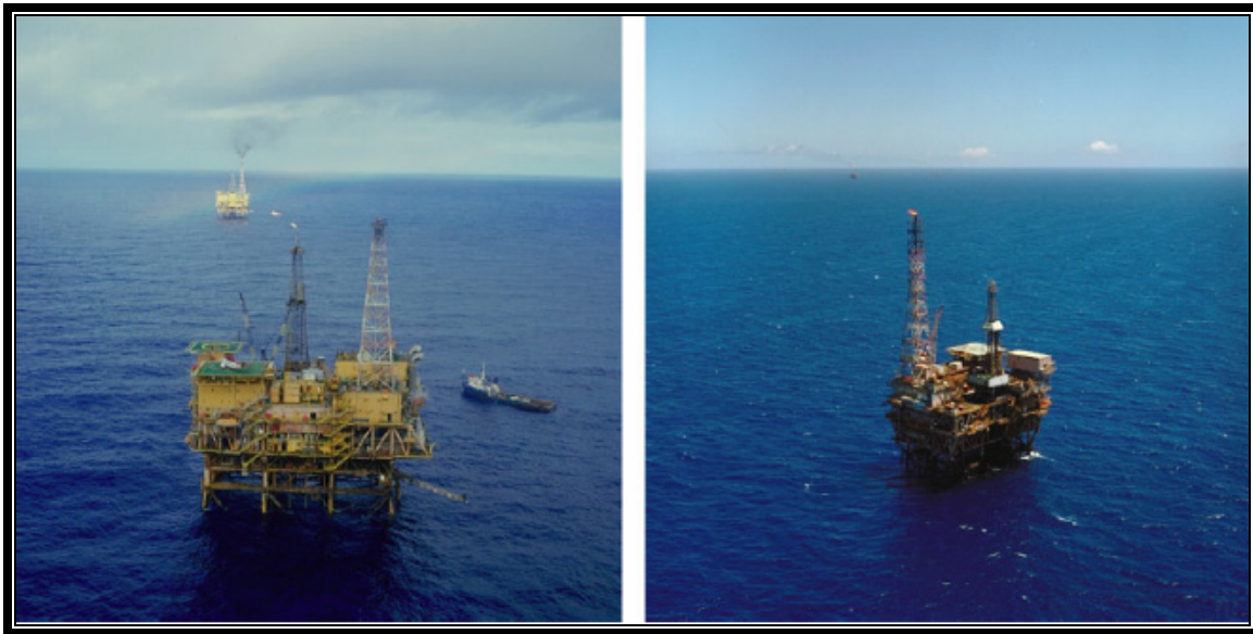
Figura 12: Foto das plataformas PNA-1 à esquerda e PNA-2 à direita. Fonte: Petrobras.
